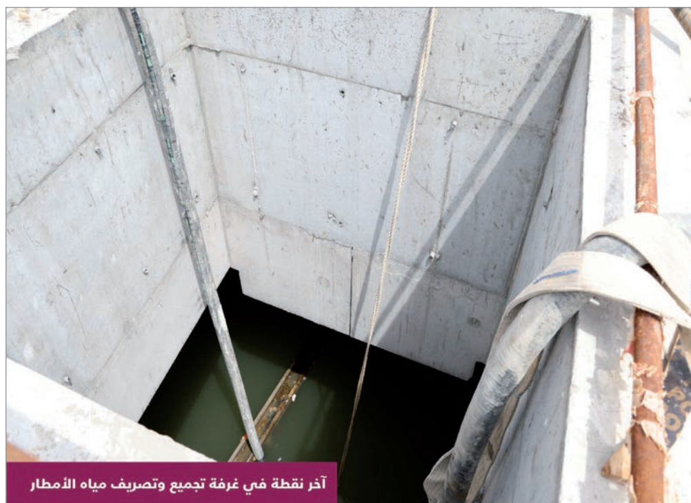
الأعمال في خزان تجميع وتصريف مياه الأمطار خلف مبنى وزارة الداخلية القديم
