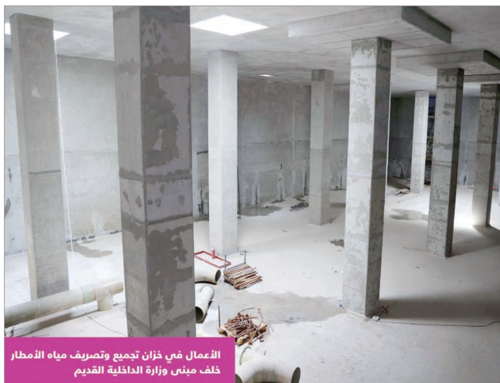
الأعمال في خزان تجميع وتصريف مياه الأمطار خلف مبنى وزارة الداخلية القديم
