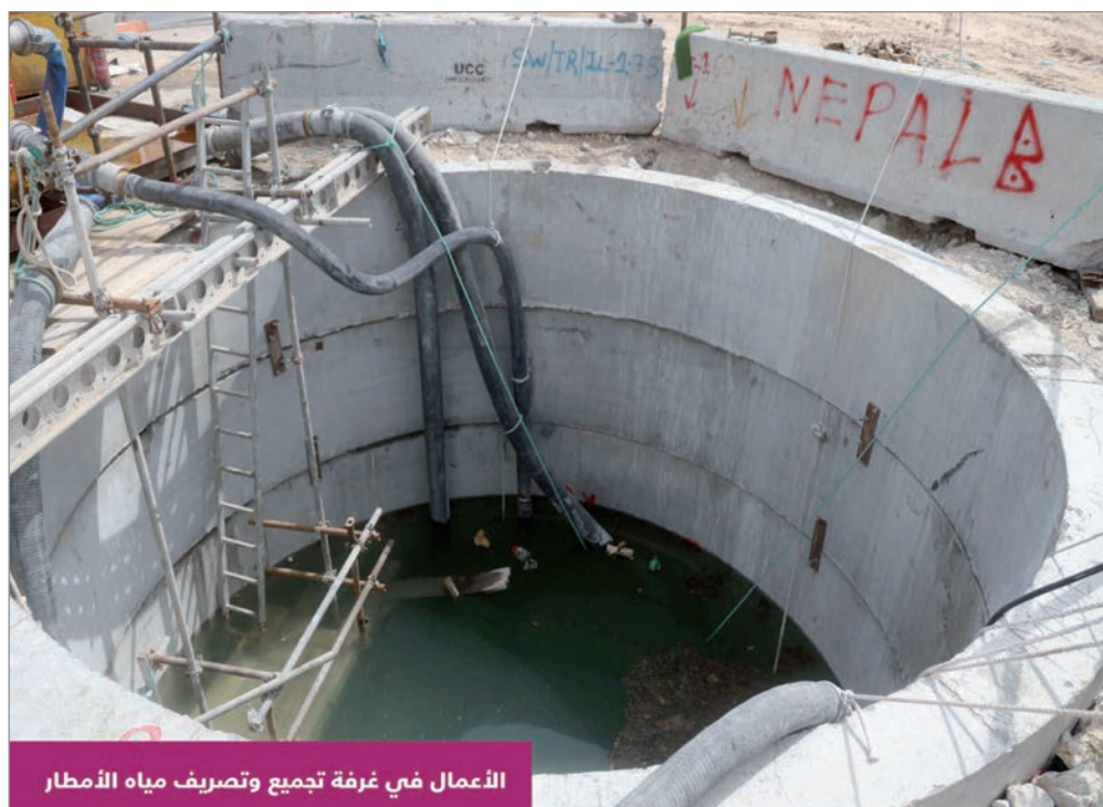
الأعمال في خزان تجميع وتصريف مياه الأمطار خلف مبنى وزارة الداخلية القديم
