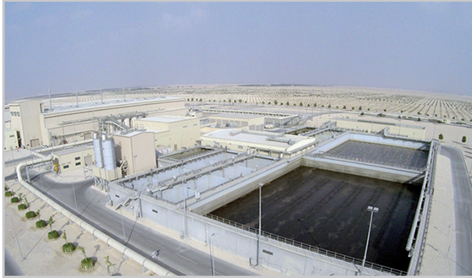
■ محطة معالجة مياه الصرف الصحي في شمال الدوحة
