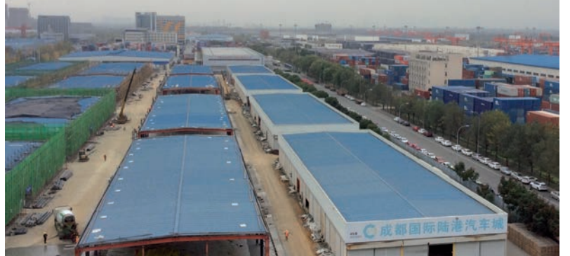
■ ميناء سكك حديد مدينة شينغدو
