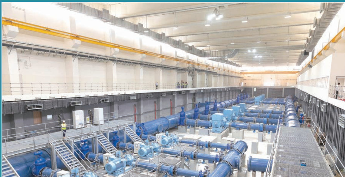
■ مشروع الخزانات الإستراتيجية الكبرى للمياه - موقع خزانات أم صلال
