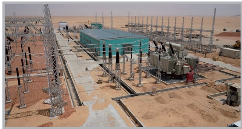
■ قطر مولت مشروع محطة ابو حمد للكهرباء
