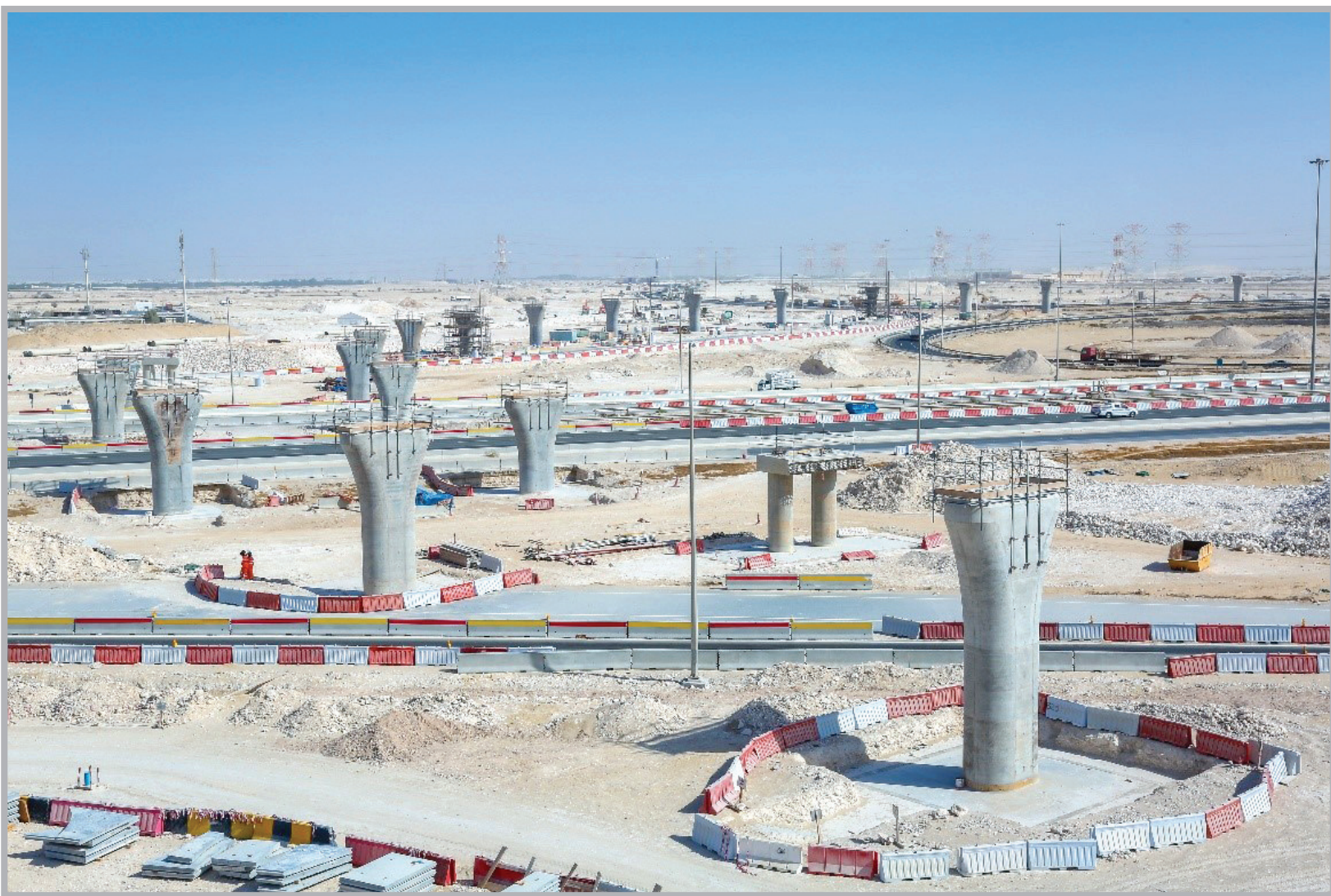
■ مشاريع وبنية تحتية قيد الإنشاء
