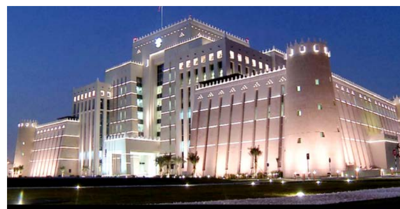
■ مبنى وزارة الداخلية
