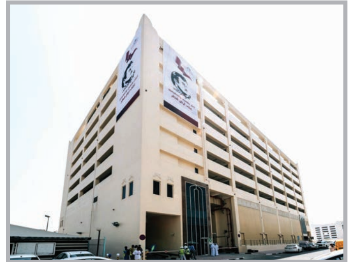
■ مبنى مواقف كهرماء متعدد الأدوار
