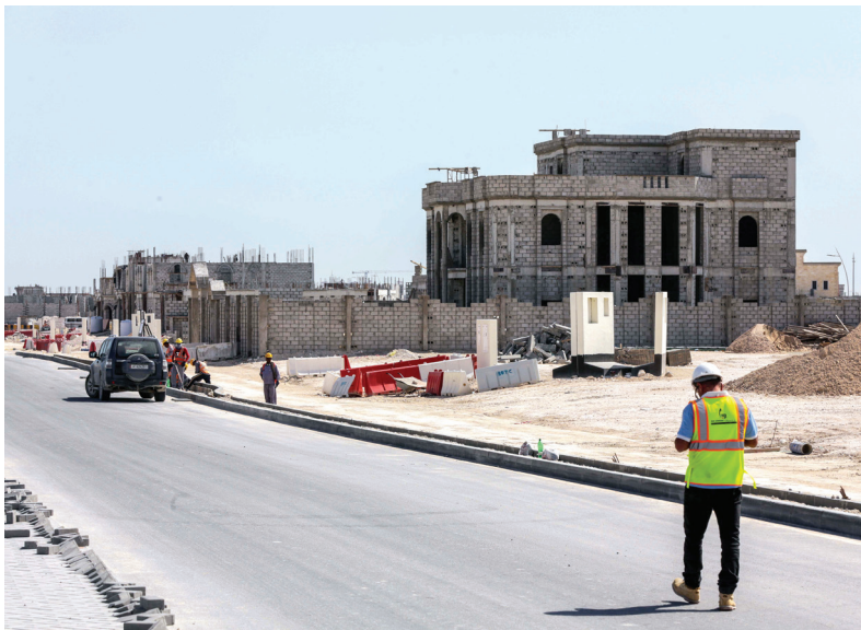
■ جانب من أعمال البنية التحتية والبناء
