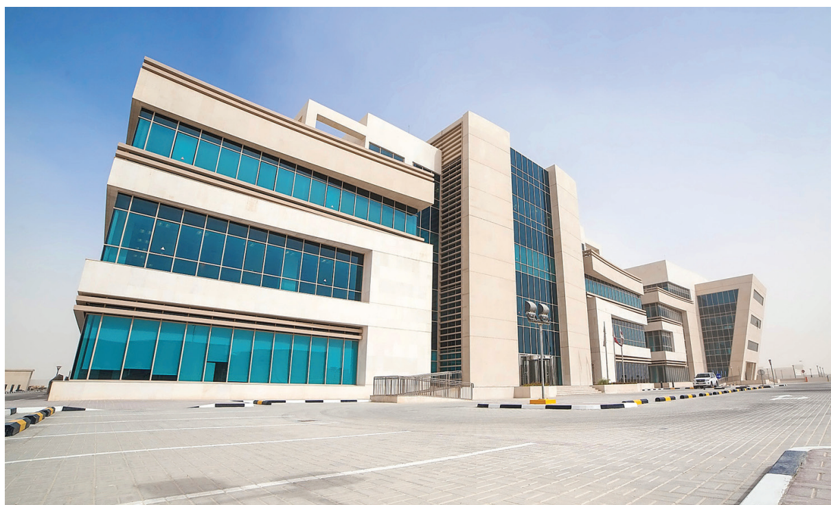
■ مبنى مركز Ooredoo للبيانات يستضيف خوادم اللجنة المنظمة لكأس العالم 2022
