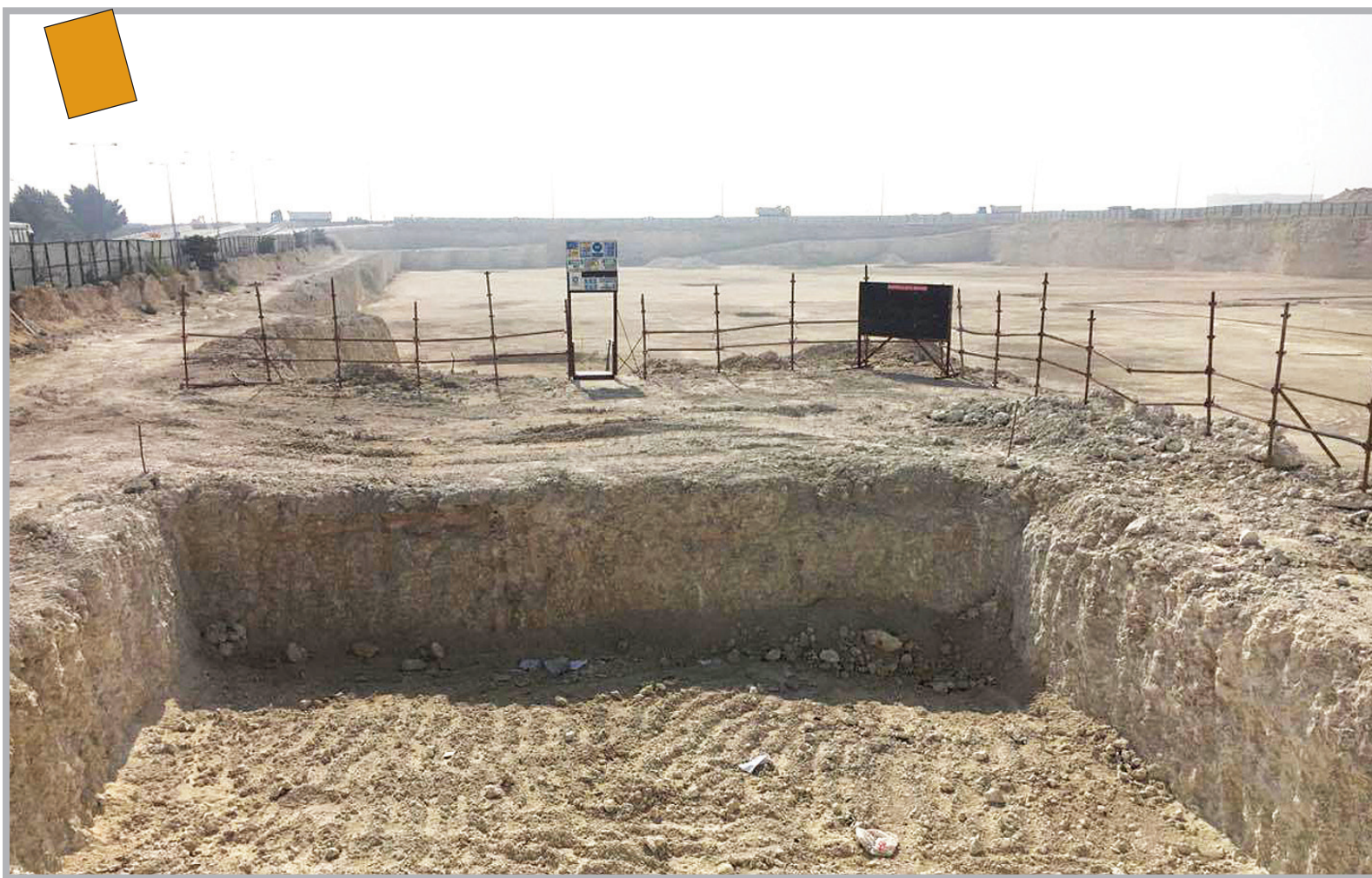
■ أعمال المشروع توقفت بعد عمليات الحفر
