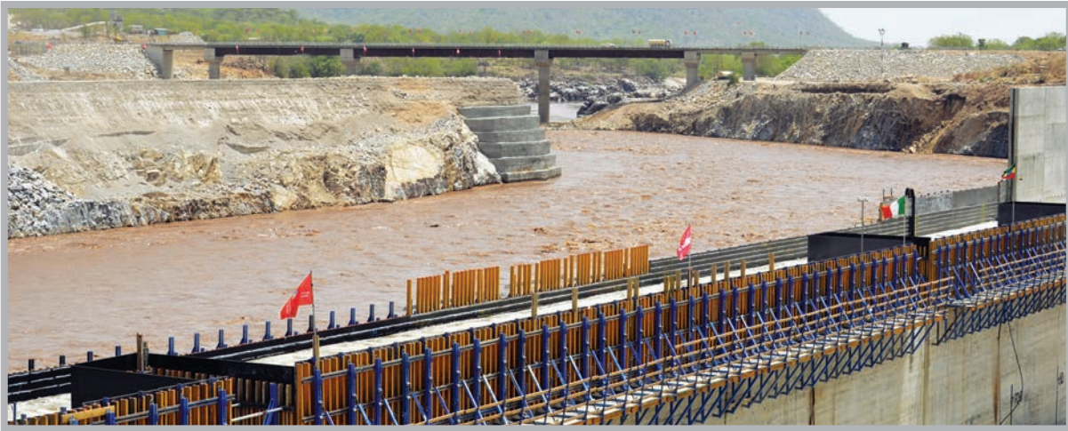
■ تواصل البناء في سد النهضة الإثيوبي
