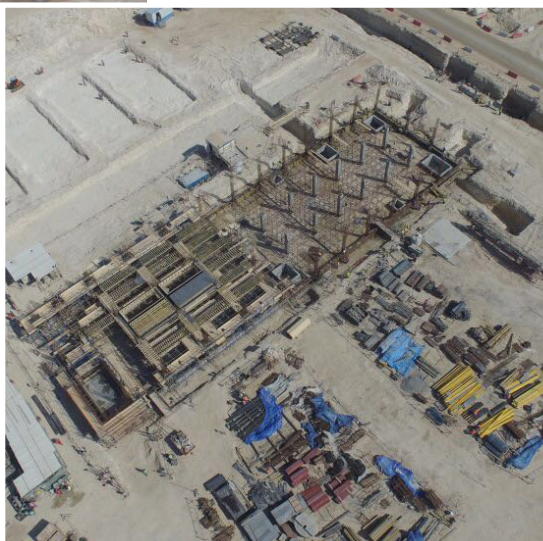
■ عمليات الإنشاءات الجارية حالياً في مشروع أم الحول
