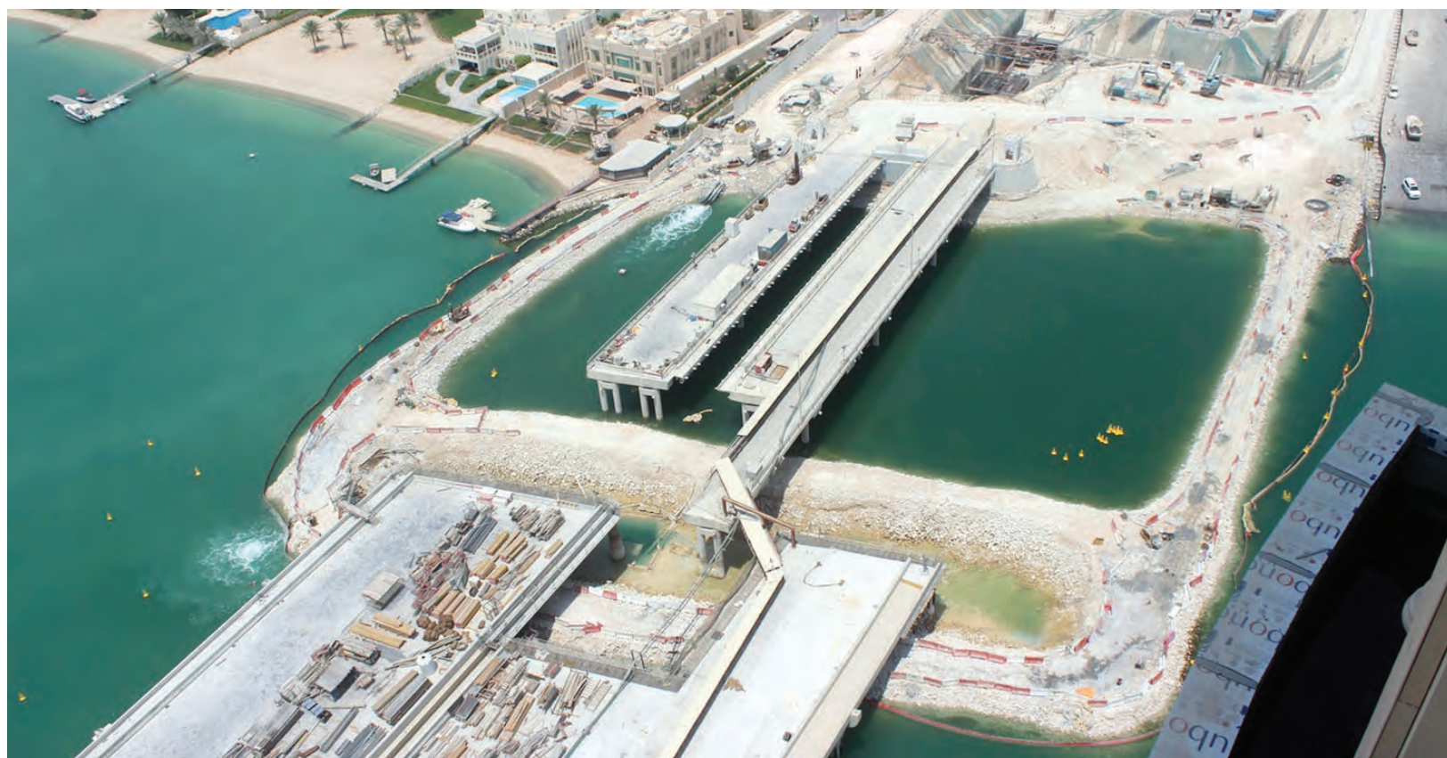
■ تطور الأعمال الإنشائية لممر العبور الشمالي ضمن مشروع أعمال طريق لوسيل السريع
