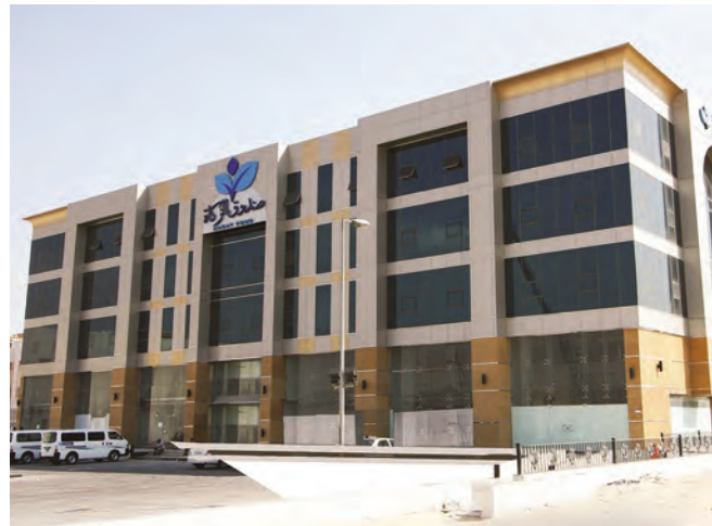
■ مبنى صندوق الزكاة
